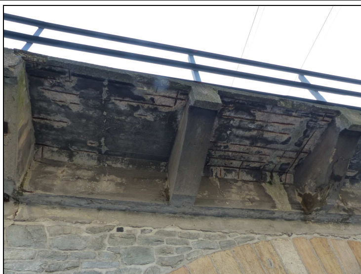
Foto č. 15 Konstrukce K 16 Chodníková konzola vpravo – z pohledu degradace betonu, koroze obnažené výztuže, průsaky
