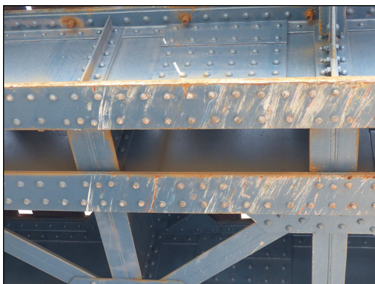
Foto č. 9 Konstrukce K 12 Vnější a vnitřní hlavní nosník vlevo Vrpy, usmýknuté hlavy nýtů a poškozená PKO od podjíždějících vozidel
