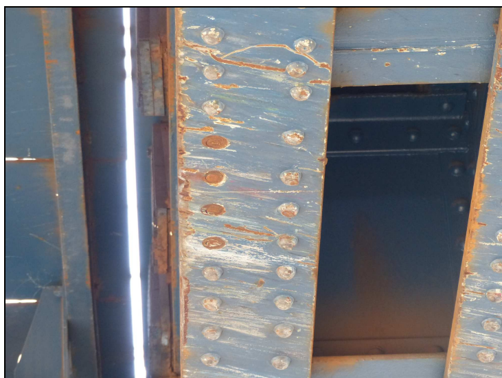
Foto č. 11 Konstrukce K 13 Vrpy od vozidel v dolní pásnici levého vnějšího hlavního nosníku, usmýknuté hlavy 4 nýtů + naražená pásnice
