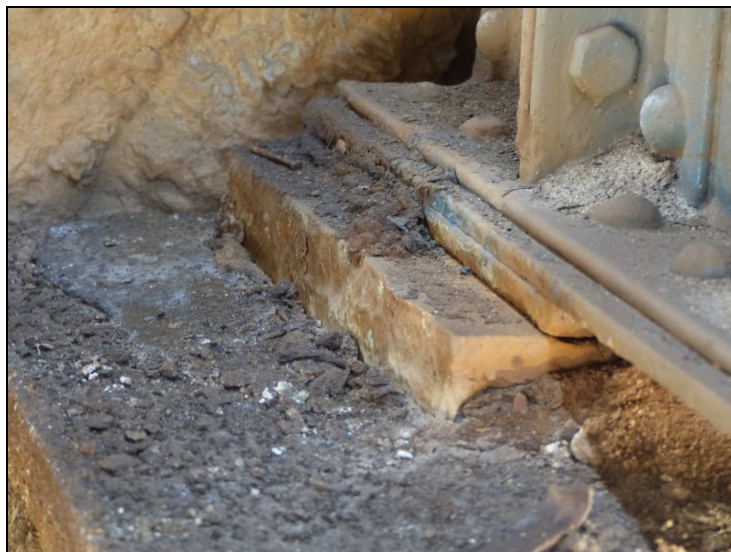
Foto č. 13 Konstrukce K 13 Pohyblivé ložisko vlevo na P 11 Zleva odtržená chybějící vodící lišta
