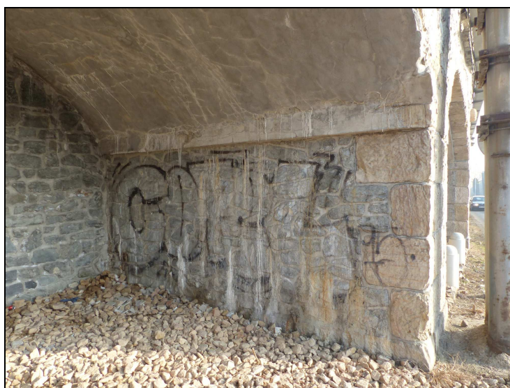
Foto č. 6 Konstrukce K 08 Průsaky s výluhy pojiva
