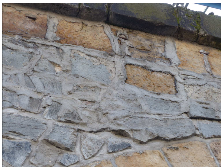
Foto č. 14 Konstrukce K 14 Čelní zed' vpravo v první polovině – svislé a šikmé trhliny po spárách i přes kameny
