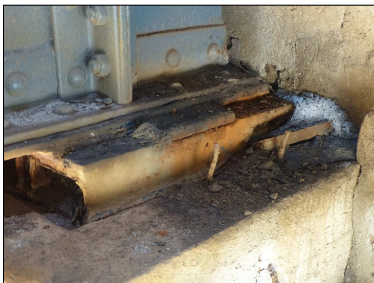
Foto č. 10 Konstrukce K 12 Pevné ložisko vpravo – zprava utržené obě zarážky
