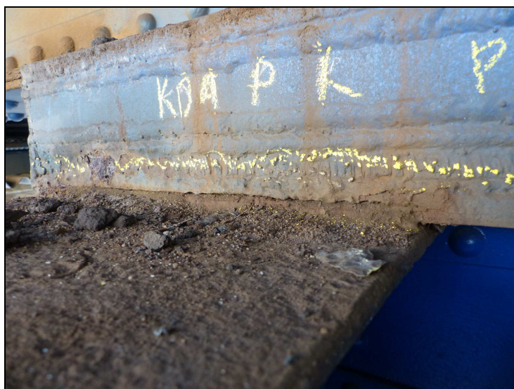
Foto č. 7 Konstrukce K 09 Pohyblivé ložisko vpravo Trhlina ve svaru zprava
