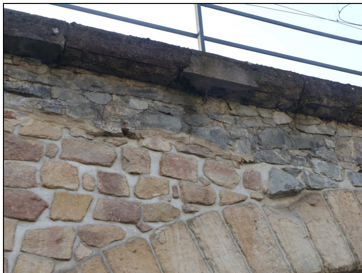
Foto č. 4 Konstrukce K 06 Čelní zed' vpravo na začátku Boulení zdiva, popraskané spárování
